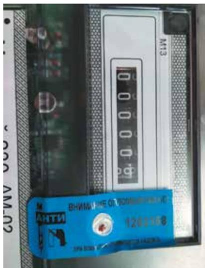
**О**дин из приемов — установка на счетчик мощного магнита. Для предотвращения самовольного вмешательства в работу приборов учета «МОЭСК» в прошедшем году установило на них 6000 антимагнитных пломб. В ближайшие два года компания оснастит ими все приборы учета, на которые возможно воздействие постоянным магнитным полем.
