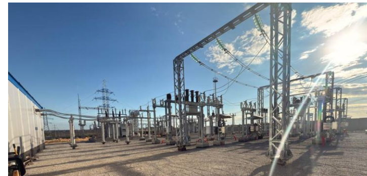
ПС 110/35/10 кВ «Задонская» завершение основных СМР – 4 кв. 2025 года ввод в работу – 2 кв. 2026 года
