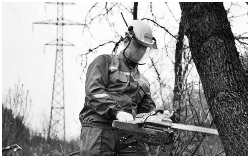
Расчистка просек ВЛ в Брянскэнерго
