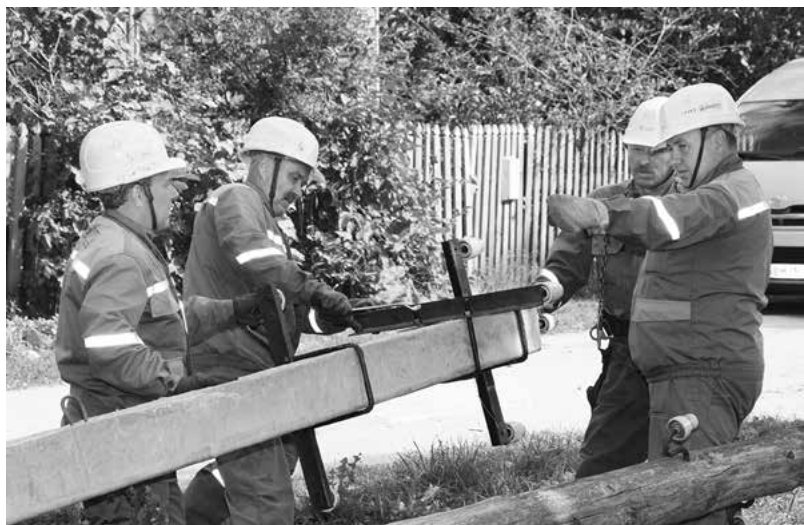
Ярэнерго: замена опор ЛЭП
