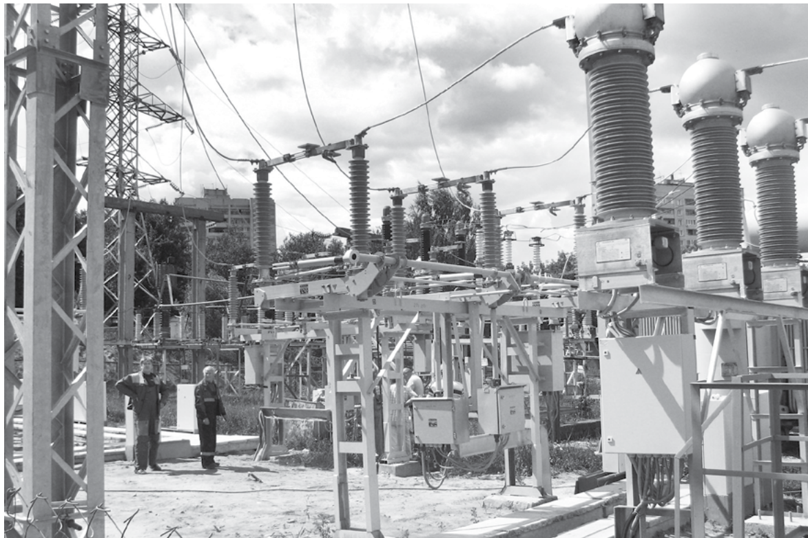
На реконструкцию ПС «Городищенская» направлено около 241 млн рублей
