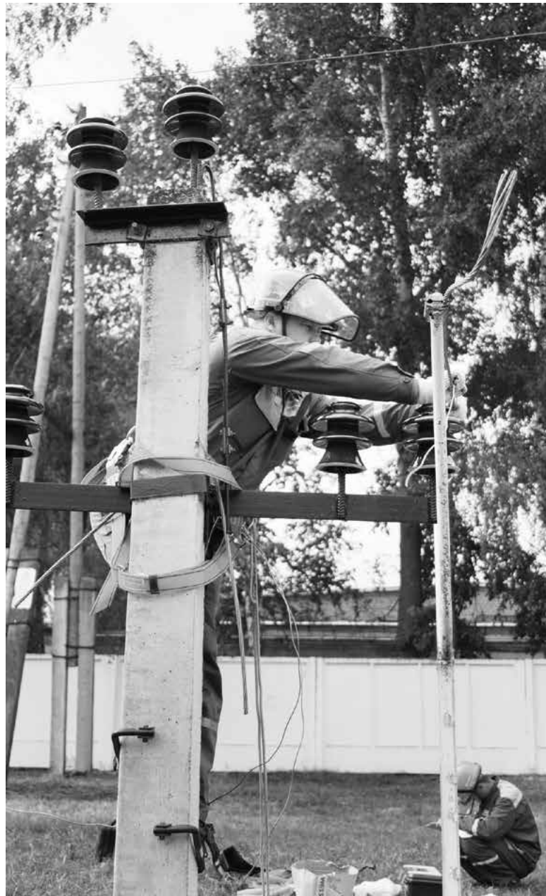
Прохождение этапа по замене вязки провода на ВЛ 10 кВ
