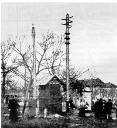
Трансформаторная будка и воздушная ЛЭП. Воронеж, 1899 год
