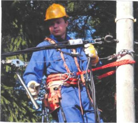
Обеспечить бригады РЭС специальными комплектами инструмента для монтажа и ремонта ВЛИ-0,4 кВ.
