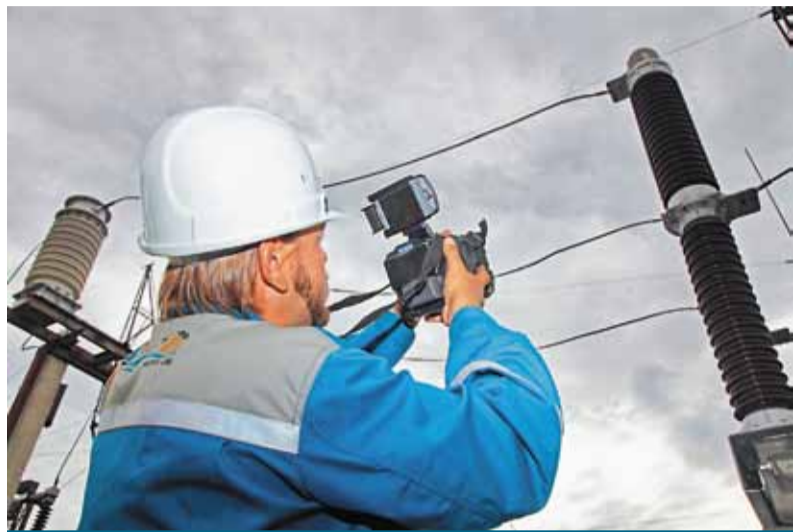
Обследование энергооборудования на ПС «Бугор»
