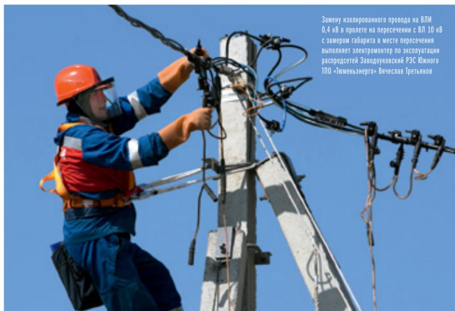
Замену изолированного провода на ВЛ 0,4 кВ в пролете на пересечении с ВЛ 10 кВ с замером габарита в месте пересечения выполняет электромонтер по эксплуатации распределителей Заводуновский РЭС Южного ТПО «Тюменьэнерго» Вячеслав Третьяков
