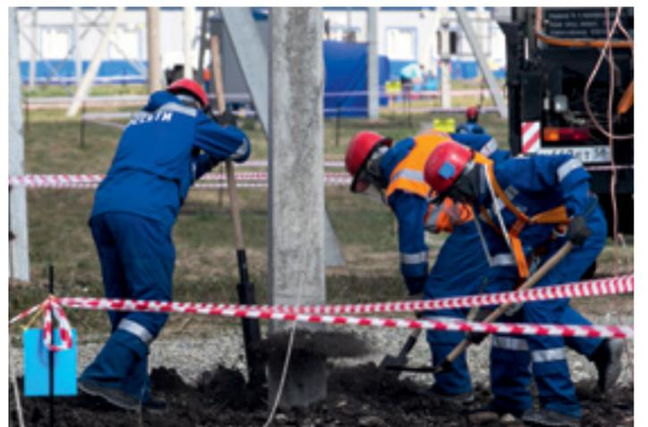
Замена промежуточной железобетонной опоры на ВЛ 10 кВ с применением механизмов. Опору закапывают монтеры МРСК Центра и Приволжья
