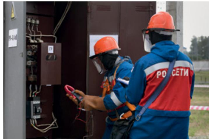
Замер сопротивления петли фаза – ноль в сети 0,4 кВ (однофазного тока короткого замыкания) и оценку соответствия параметров защитного оборудования линии проводят представители «Тюменьэнерго»
