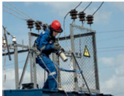
Замена дефектного проходного изолятора 10 кВ на КТП 10/0,4 кВ. Измерение сопротивления заземления КТП 10/0,4 кВ
