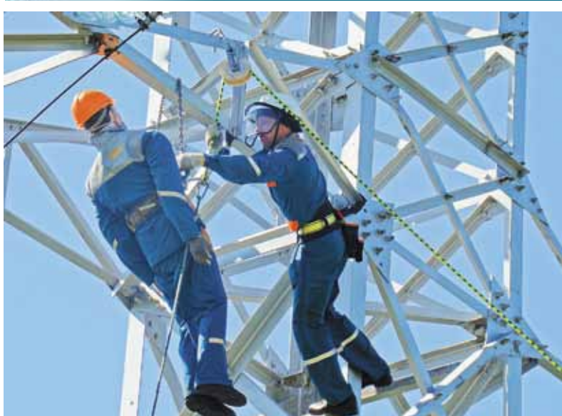
Электромонтеры снимают пострадавшего с опоры
