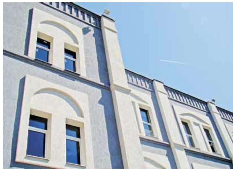
Подстанция 110 кВ «Центральная»
