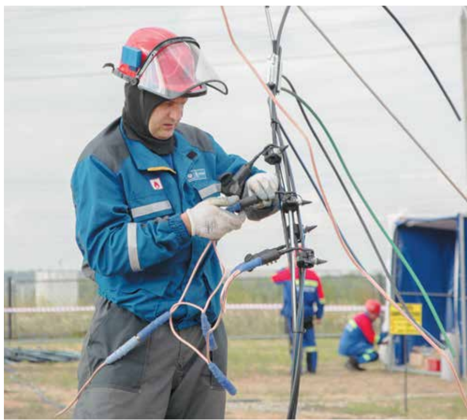
Мастер Владимир Богданов меняет изолированный провод на ВЛИ–0,4 кВ
