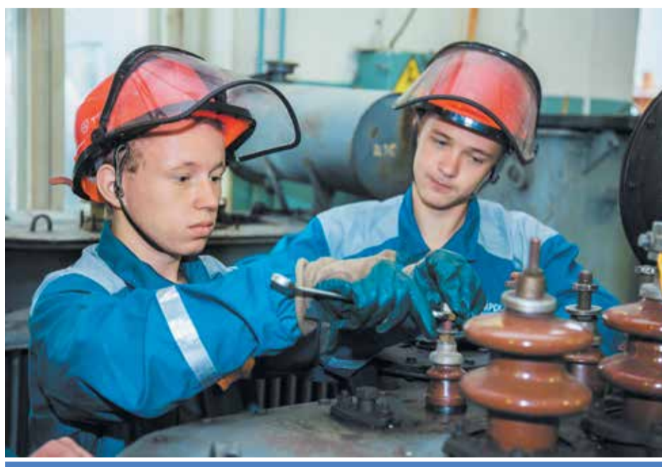
Участники стройотряда Костромаэнерго проводят ревизию трансформатора в Городском РЭС
