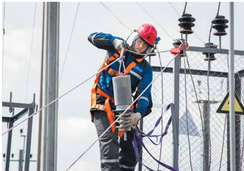
Электромонтер Алексей Ковалев проводит замену дефектного изолятора на КТП 10–0,4 кВ
