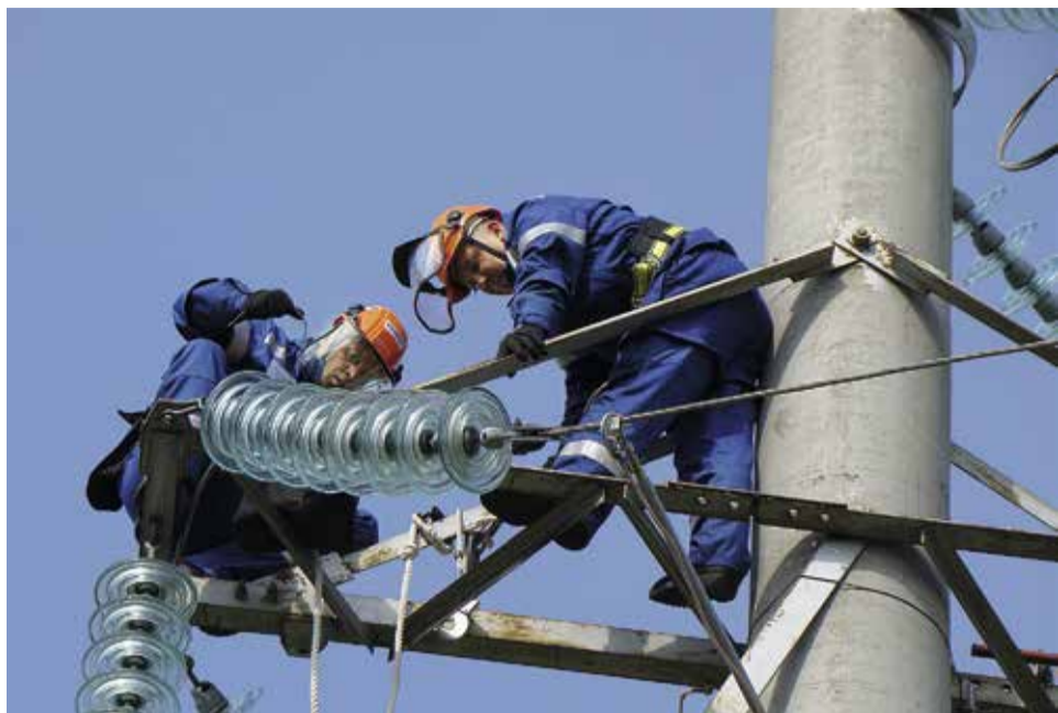
Проведение ремонтных работ – одно из условий подготовки к ОЗП.
