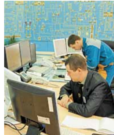
Центр управления сетями Белгородских электросетей
