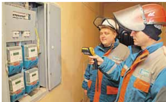
Тепловизионный контроль внутридомовых сетей
