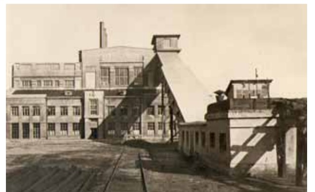
Белгородская ТЭС — одна из электростанций, построенных по плану ГОЭЛРО
