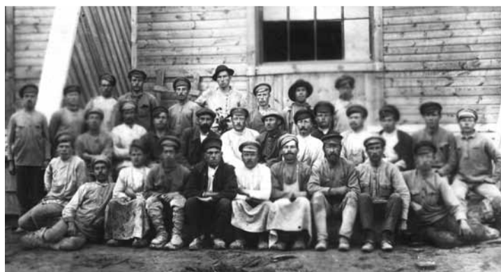
Инженер-электроэнергетик Александр Винтер и бригада строителей Шатурской ТЭС
