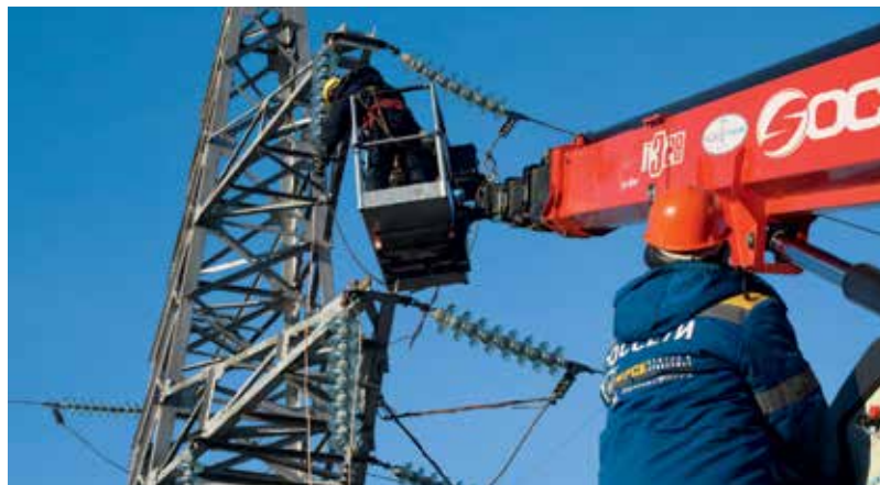
Монтаж высокотемпературного провода на ВЛ «Кама-РП Мостовое»
