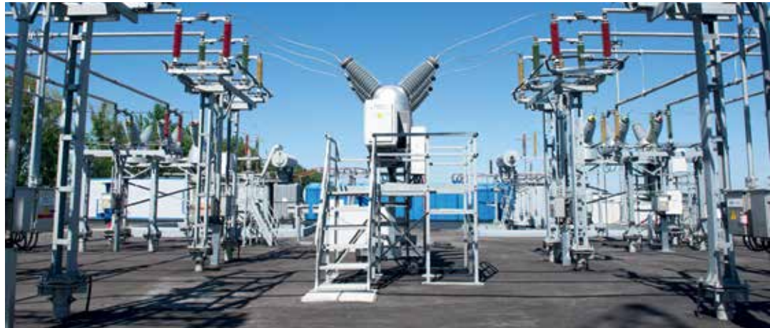
В результате реконструкции мощность ПС «Шеино» увеличилась на 6,8 МВА
