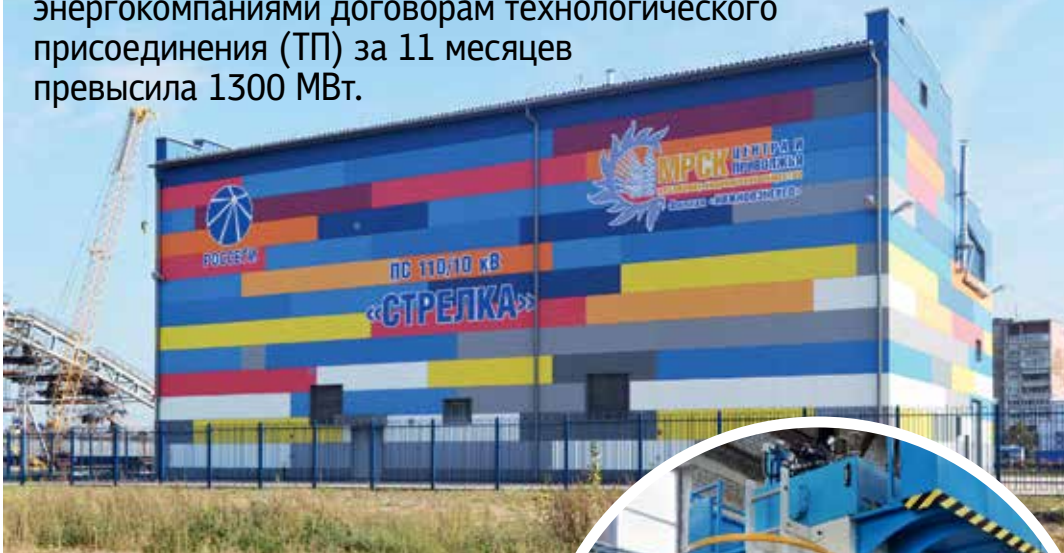
Для техприсоединения объектов ЧМ-2018 по футболу специалисты «Нижовэнерго» в 2014-м году ввели в эксплуатацию новую ПС «Стрелка»
