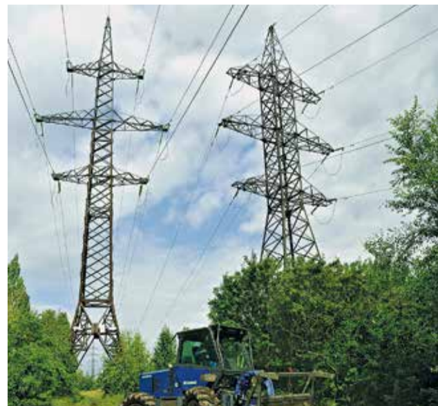
Расчистка просек ЛЭП — одно из важных мероприятий ремонтной кампании
