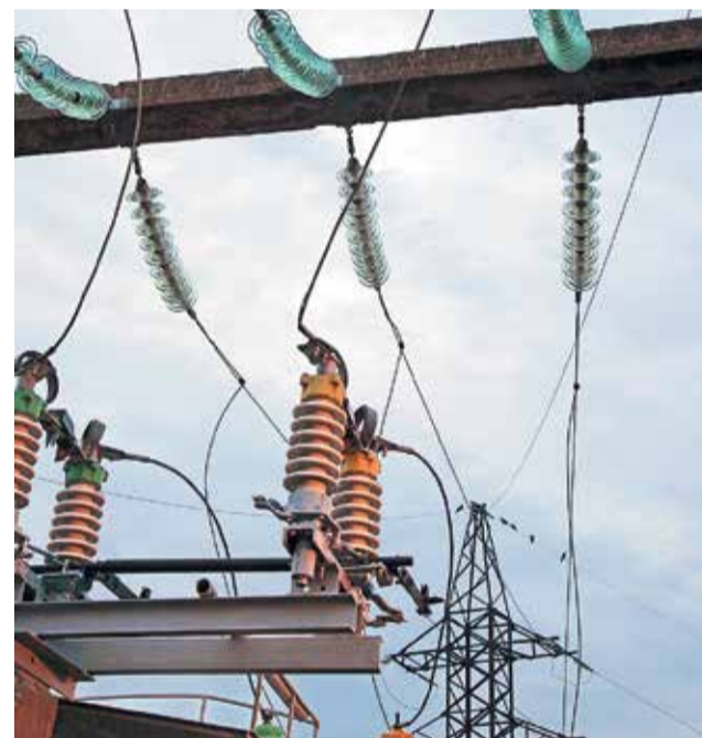
Замена провода на большее сечение на перегруженных ЛЭП дала ощутимый эффект в части снижения потерь электроэнергии в сетях
