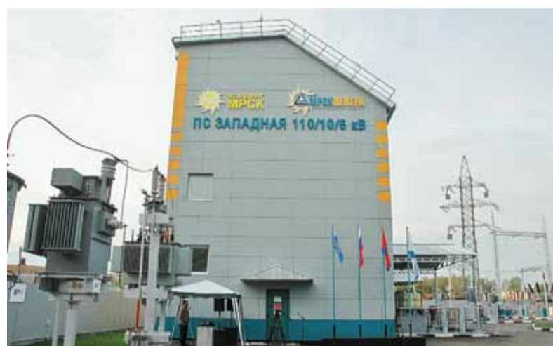
После реконструкции мощность подстанции увеличилась вдвое
