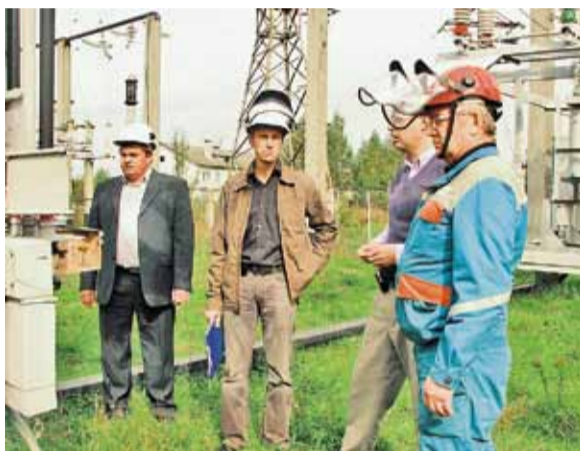
Проверка оборудования на ПС «Жирятинская»
